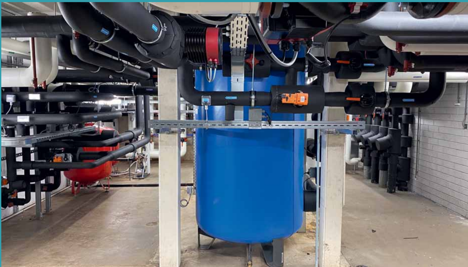
Technische ruimte met buffervaten.
